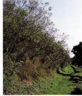
樹林化を目的として、有機厚層基材の中に木本類の種子を混合して吹付した法面。ニセアカシアが優先したため、他感作用が強く、ここ数十年間は植生遷移が望めない。
