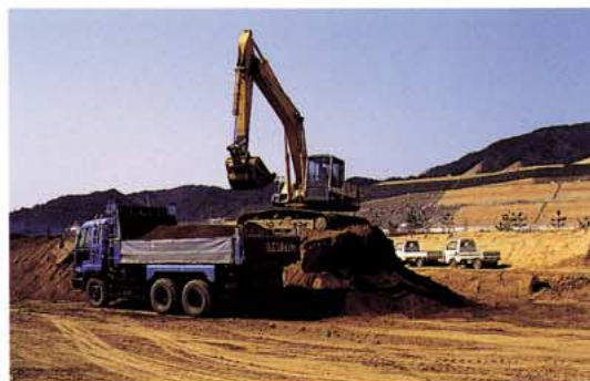
ヤードでの客土の改良
