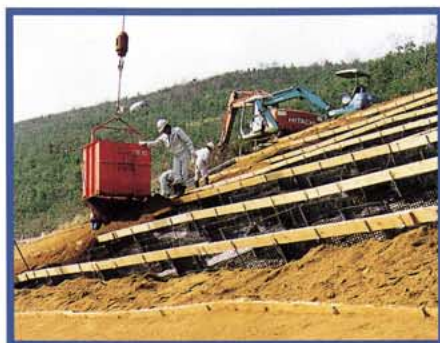
④ 改良客土を投入・敷き均し
