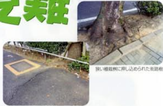
舗装下のすき間に根が入り、クラックの原因を作る。
