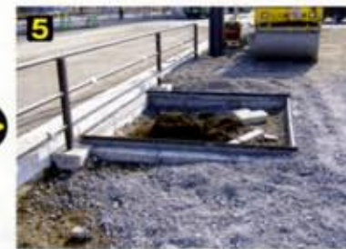
緑化適用基礎と外枠を施工して、路盤(RC)を転圧。
