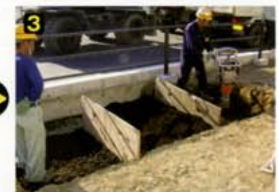
根系伸長域にパワーミックスRを一層20cm厚みで投入し、ダンパにて転圧を加える。
