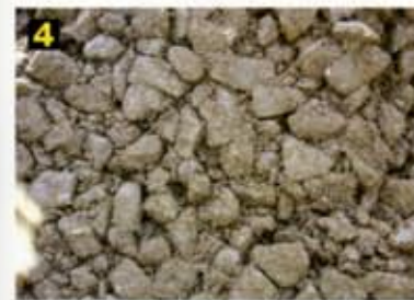
転圧を加えた後のパワーミックスRの状態。根の伸長できる適度なすき間が見える。
