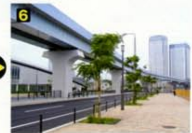
植栽およびインターロッキングブロックを施工して完成。
