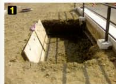
路床部分に生育用基盤を掘る。
